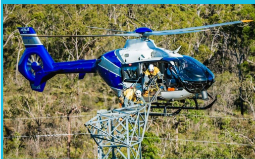
送電網の整備作業中ヘリコプター
